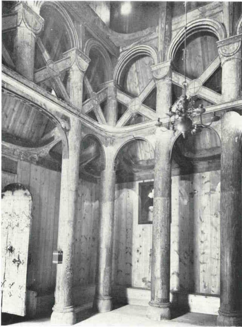
Fig. 6. Høprekstad stavkirkes skip sett mot nordvest. Den indre reisingens kapiteler og buer er markert med profiler etter forbilde av samtidens stenbasilikaer. Andreaskorsene er satt inn etter at kirken var reist og skjærer seg uorganisk inn i kapitelenes.
